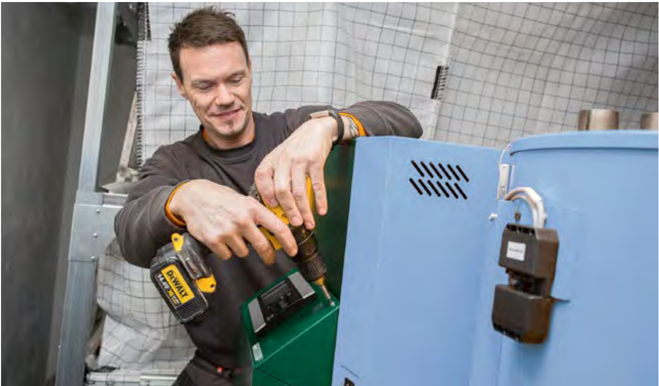
Die Installation des Pelletkessels wird genauso bezuschusst wie das Lager oder die Entsorgung von alter Ölheizung und Öltank
