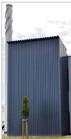
Abb. 34: Beispiel eines eingehausten Pelletsilos zur Außenaufstellung
